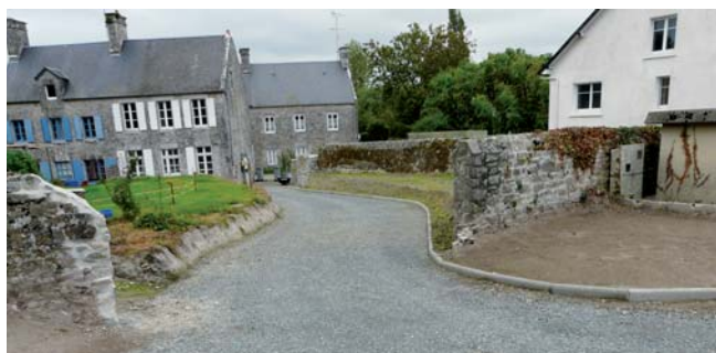
Un nouvel accès pour la Salle de l'Effort
