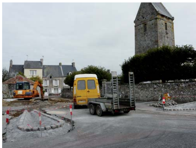
Début des travaux sur la Place de Grimouville
